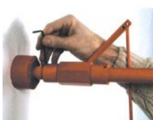
4. Išlyginus dušo galvutę, ją pritvirtinkite dviem šešiakampiais varžtais.
